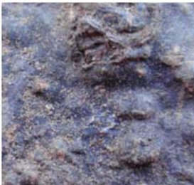
Fig. 3. Formațiuni din crusta de coroziune cu profilul în relief
