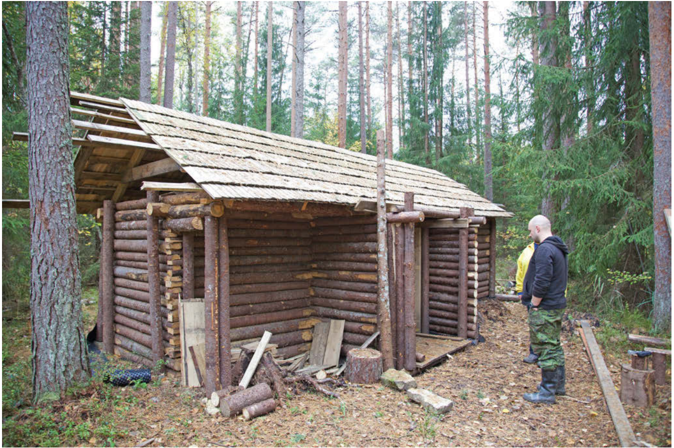
Metsavendluse uurija Martin Andrelleri eestvõttel valmis 2013. aastal Põrgupõhja punkri rekonstruktsioon. Esialgu oli see okupatsioonide muuseumi teemakohase näituse eksponaat, pärast näitust toodi ehitus punkri asukoha lähedale metsa
