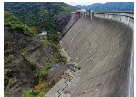
弥栄ダム 堤高 120 m、堤頂長 540 m、総貯水容量 112,000,000 m 3 の重力式コンクリートダム
