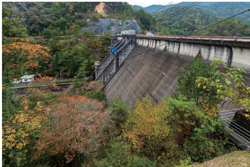
小瀬川ダム 堤高 49.0 m、堤頂長 158.0 m、総貯水容量 11,400,000 m 3 の重力式コンクリートダム
