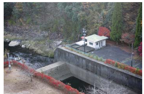
小瀬川発電所
