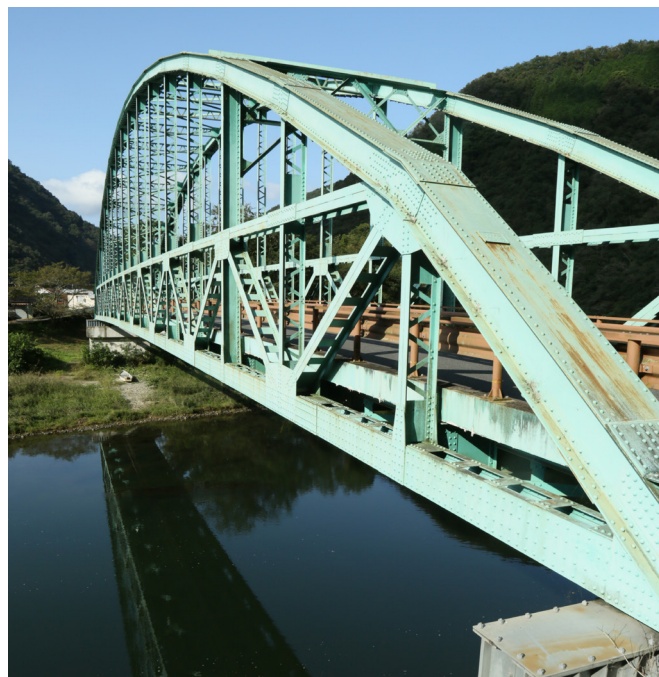
田井橋 昭和12年竣工 下路ランガートラス1連 架け替えられた田井橋の支間長（88m）は、ランガー形式の道路橋としては日本一。
