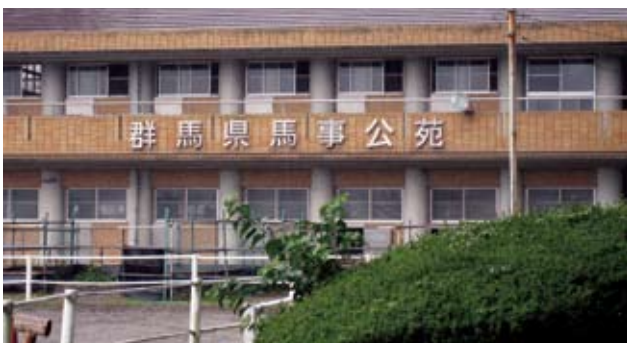
昭和61年3月に竣工した管理棟
