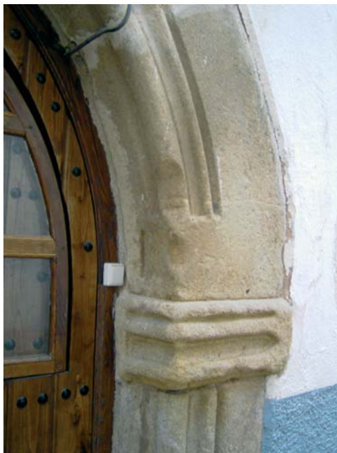
Fig. 64. Vivienda nº 29 de la calle Derecha de Alburquerque, con el hueco para la mezuzá y al lado dos rebajes pulidos en la arista y baquetón.
