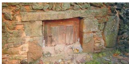
Fig. 24. Castelo Rodrigo. Interesante puerta con rebajes en las jambas, cruz a la dcha. y menorá a la izqda.
