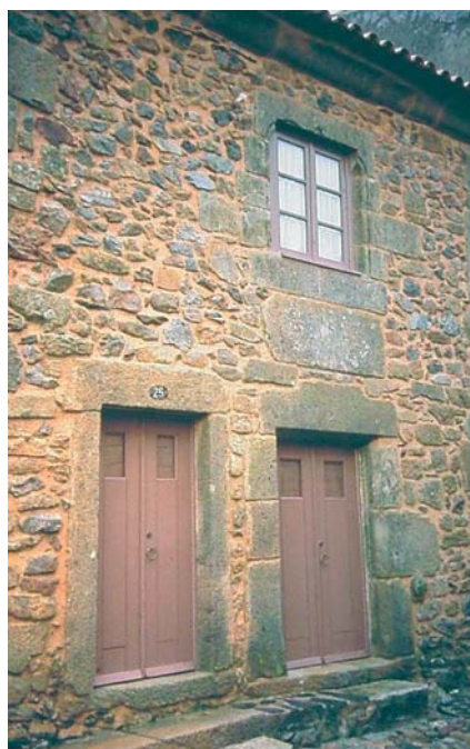
Fig. 22. Castelo Rodrigo. Casa arquetípica del XV, con rebaje y ventana manuelina.
