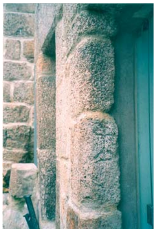
Fig. 28. Guarda. Puerta del XV-XVI, con «cruz de converso» en la jamba.
