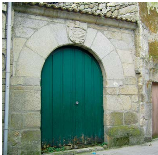
Fig. 49. Ribadavia. Puerta del s. XV-XVI con rebajes en ambas jambas.
