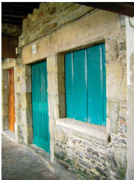
Fig. 61. Betanzos. Casa en los «Soportais da Fonte de Unta» con rebajes en la jamba de la puerta.
