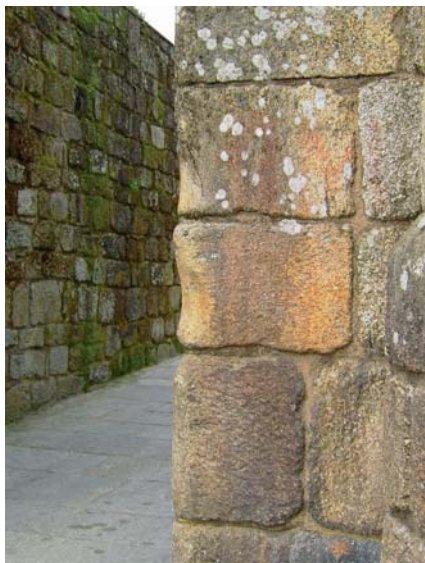
Fig. 47. Ribadavia. Rebaje pulido en la Porta Nova de la muralla.
