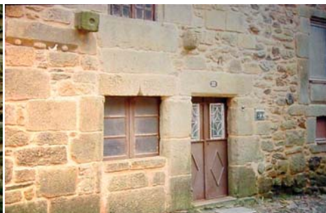
Fig. 20. Castelo Rodrigo. Casa con rebaje, y dintel con inscripción hebreaica.
