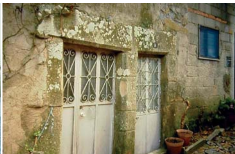
Fig. 18. Castelo Rodrigo. Casa con rebaje y cruz.
