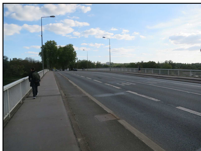
Piste cyclable unidirectionnelle à mi-hauteur (pont du Sanitas)
