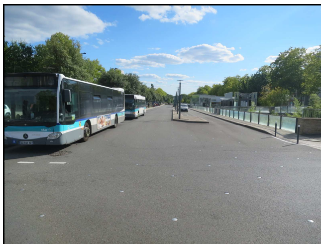
Pôle intermodal à la station de métro Henri Fréville
