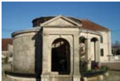
Fontaine-lavoir de Semmadon (70) Fontaine de carrefour éditée en 1844 comprend un dispositif de circulation de l'eau dans l'ordre décroissant de ses qualités sanitaires
