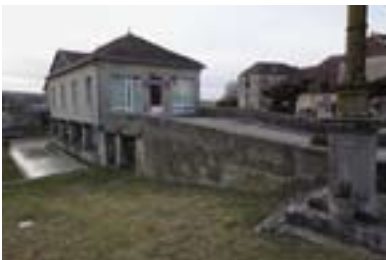
Mairie-lavoir de Mailleroncourt St-Pancras (70) La mairie-lavoir-égayoir du XIX° est un bâtiment public plus qu'original.
