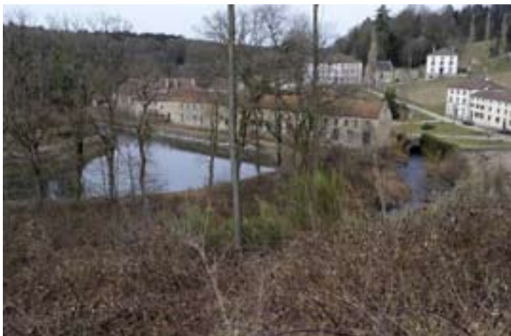
Manufacture Royale de Bains les Bains (88) La Manufacture Royale de Bains les Bains est une ferblanterie créée en 1733. L'ensemble du site du XVII° siècle comprend des bâtiments industriels, comme la halle au charbon, divers ateliers, mais également un château, une chapelle et des logements d'ouvriers.
