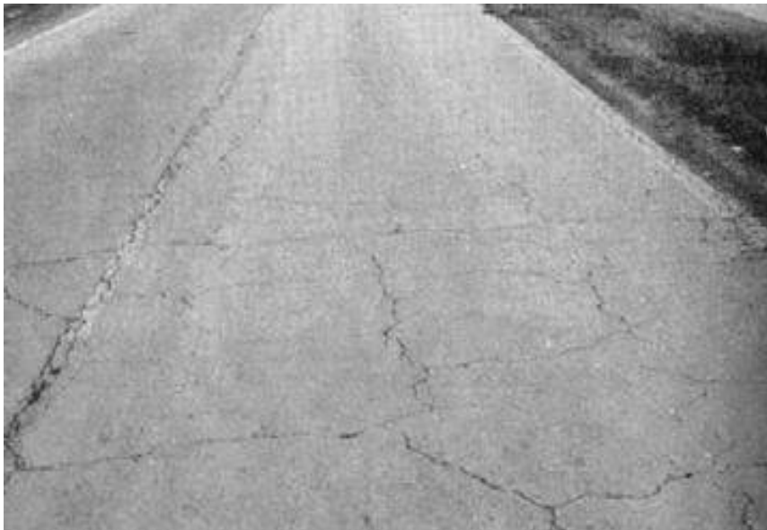
Gambar 1.4. Retak pada permukaan yang disebabkan suhu yang sangat rendah [4]
