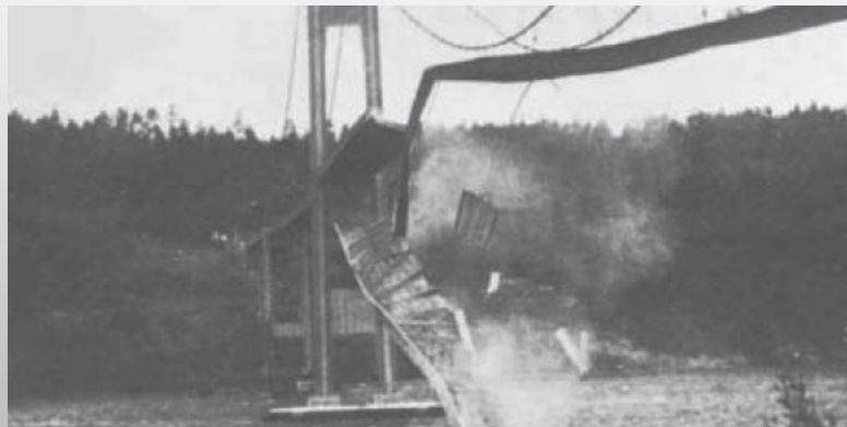
Gambar 15.2. Gelombang Angin Merusakkan Jembatan Tacoma
