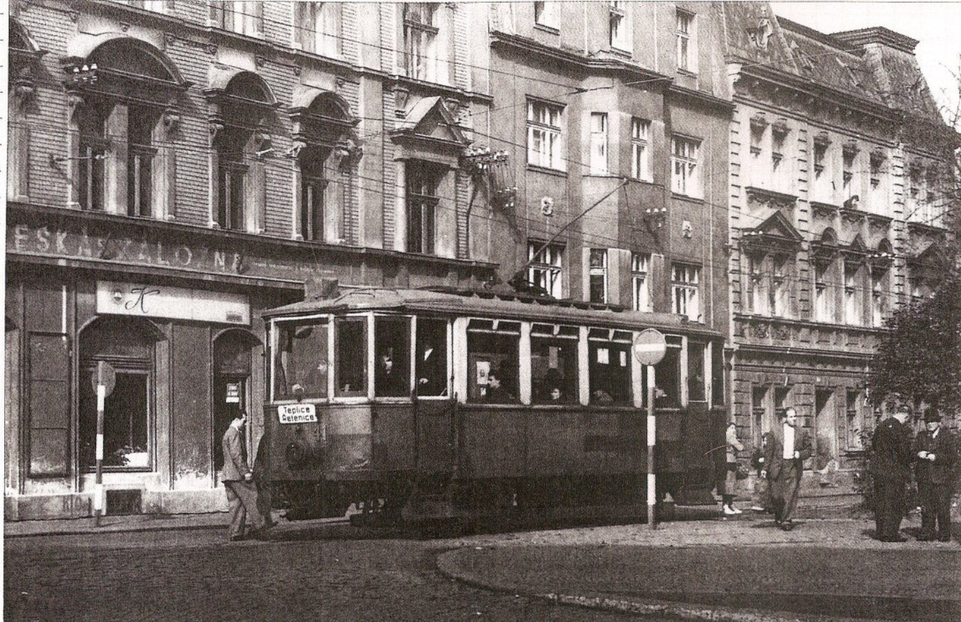
Kurz nach Fertigstellung des zweiten Gleises zwischen Turn und Schulplatz wurde Tw 41 am 27. September 1953 bei der Roten Kirche in Turn im Bild festgehalten. Cettineo
