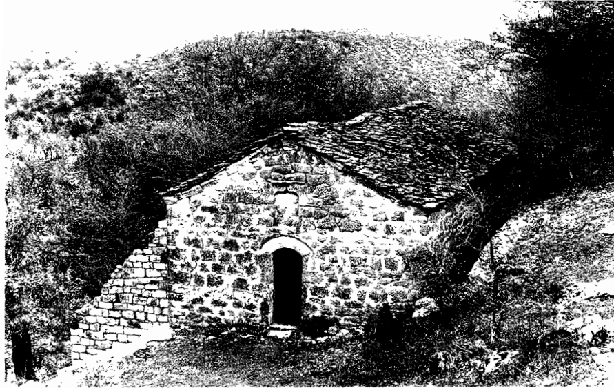
Abb. 1. Außenansicht von Südwesten.
