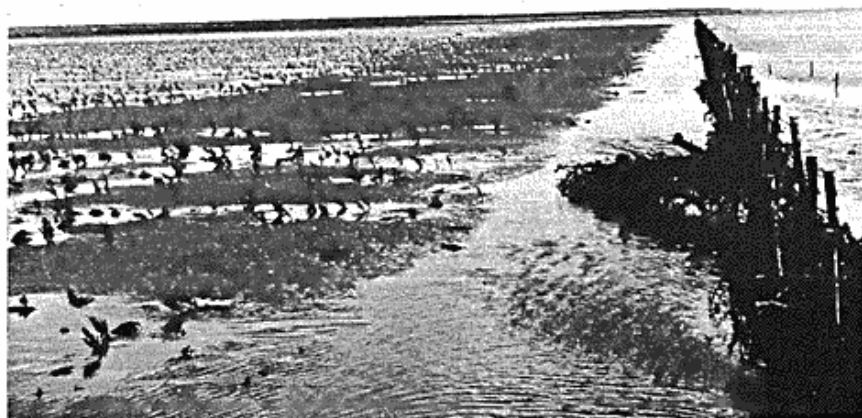
Fig. 10. Læbanken bag en faskinlånning på vaden ved Rejsby. Langs låningen er der sket en kraftig udkolkning, og materialet er aflejret i en afstand af 2—40 m bag den. Denne bank giver gode betingelser for kvellerplanterne og skal virke som „frøbed“ for områderne indenfor. Opsætningen af låningen fandt sted i efteråret 1953, og billedet er taget i sommeren 1954. Den senere udvikling ses af fig. 11. Bruddet på låningen skyldes drivende vraggods.
