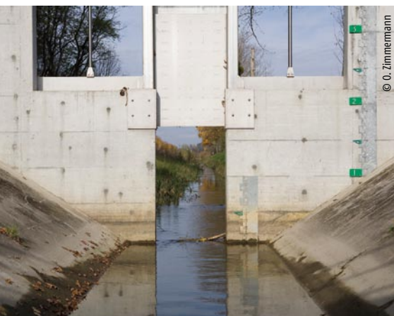
Vanne construite au Pont de la Motte pour réguler les débits.
