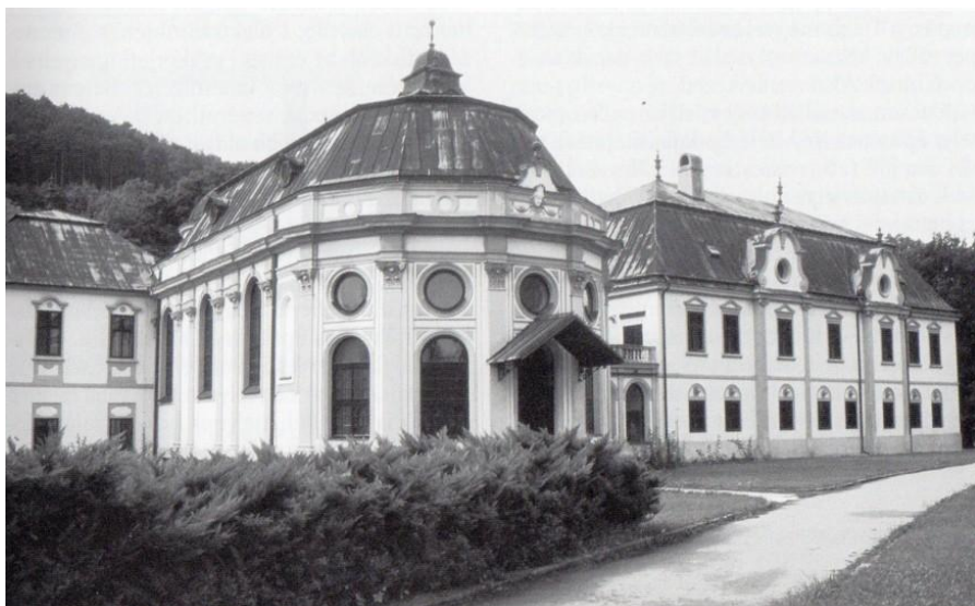
233. Tökésújfalú, Haupt-Stummer-kastély. Ismeretlen építész, 1892.
