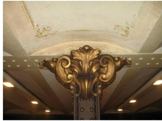
102. Poroszsüvegboltozat szegecselt vaspillérrel és vasgerendával.
