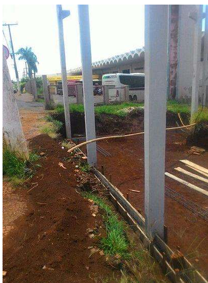
Figura 02 – Pilares pré-moldados da superestrutura sobre o bloco de fundação.
