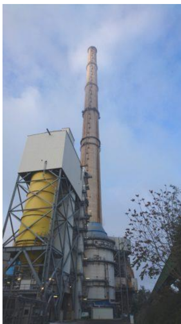
©Diades. Inspection de la plus haute cheminée de France à 297m à Gardanne pour Uniper
