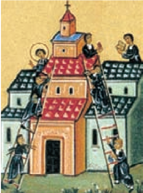
Construcción de la casa del Hermitage.
