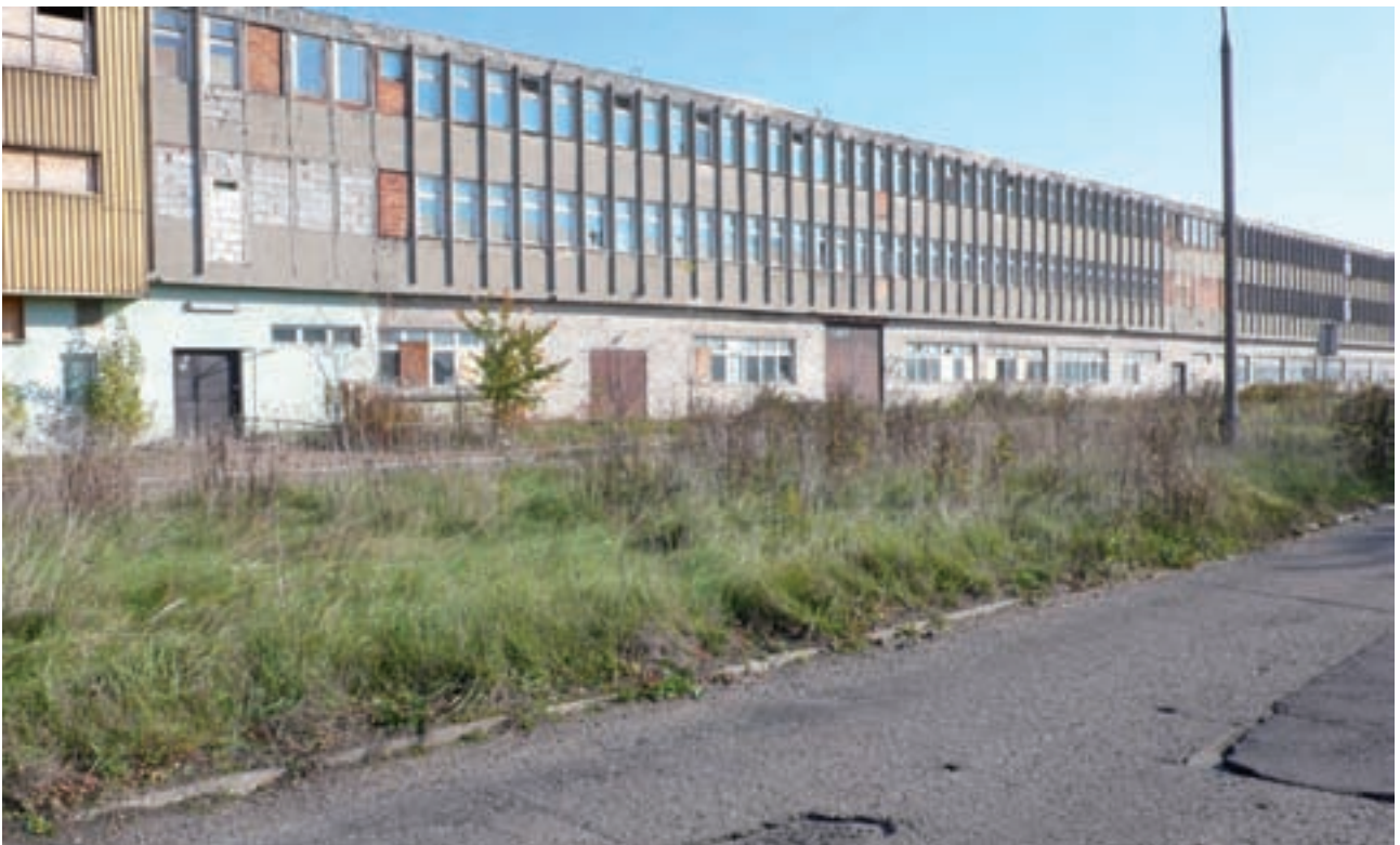
Fot. 179. Październik 2013 r., widok dawnej hali produkcji silników przy ul. Posąg 7 Panien w Ursusie. Część okien zamurowana bądź zabita płytami, hala chyba przeznaczona do rozbiórki
