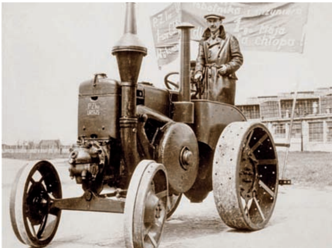
Fot. 42. Jeden z pierwszych wykonanych ciągników Ursus C45 wyjeżdża w 1947 r. na defiladę 1-szo majową. Wyposażony w stalowe koła, tylne z odkręconymi ostrogami nie ma w ogóle instalacji elektrycznej (fot. ze zbiorów Muzeum ZM Ursus)
