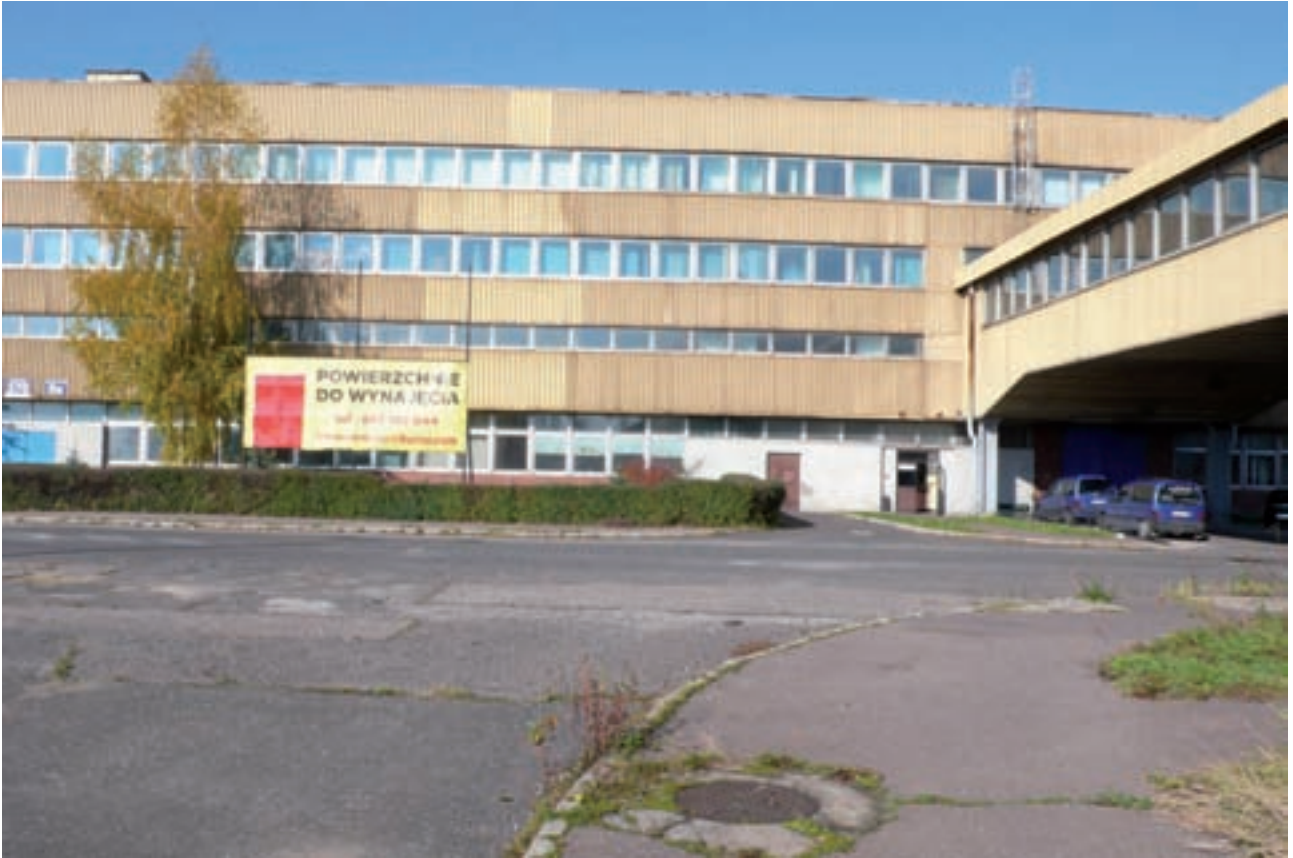
Fot. 178. Październik 2013 r., widok dobrze utrzymanego budynku przy ul. Posąg 7 Panien w Ursusie, będącego własnością Polskiego Holdingu Obronnego (dawniej BUMAR) [39]. Tu zakończyli swoją pracę konstruktorzy Ursusa
